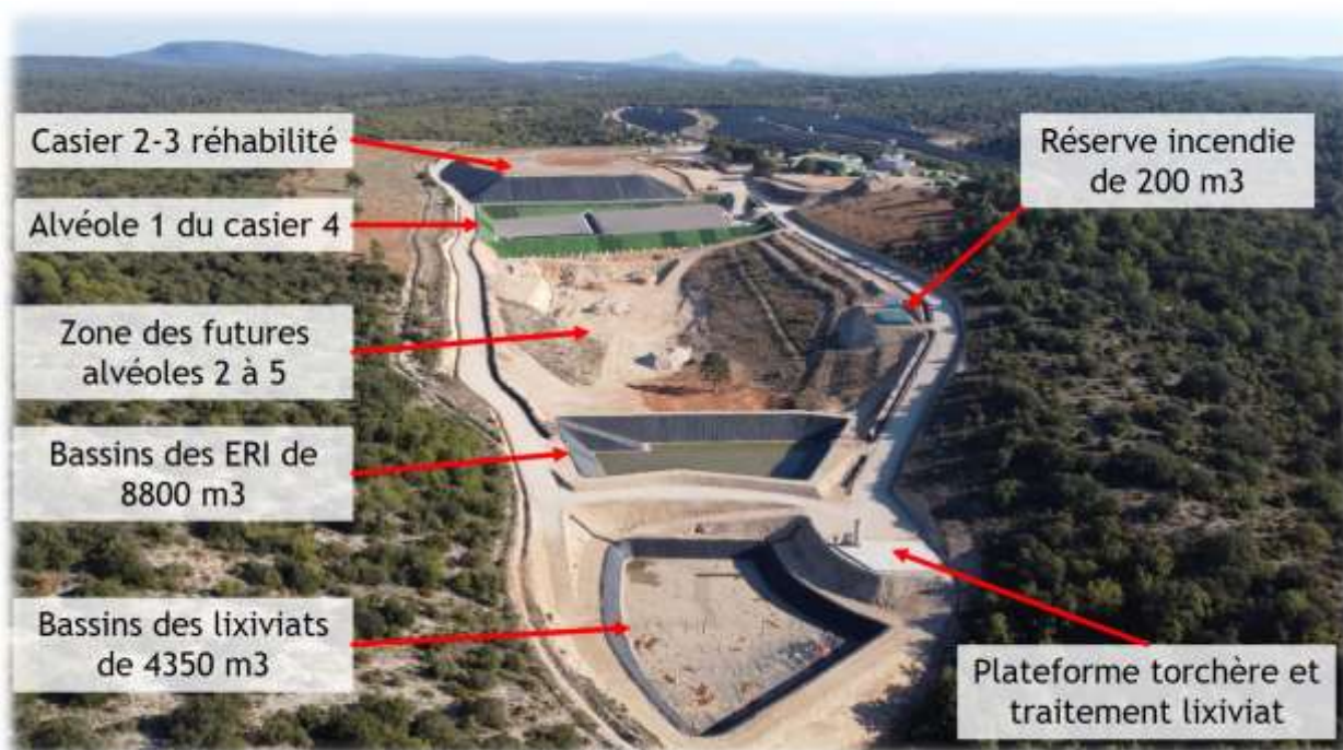
L'ISDND de Ginasservis le 30 septembre 2021
