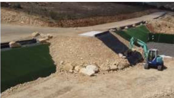
Quai déchargement alvéole 1 du casier 4
