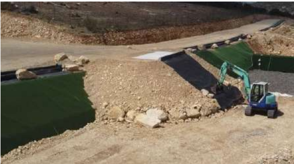
Quai déchargement alvéole 1 du casier 4
