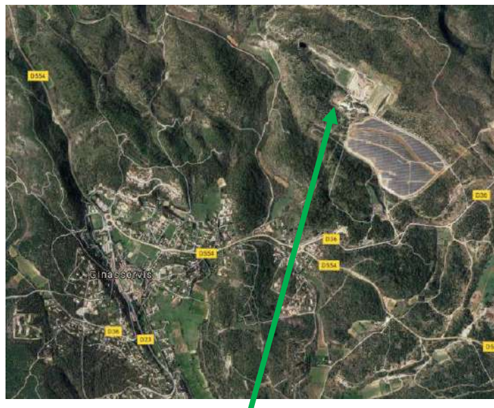
ISDND vu du ciel (Google Maps)
