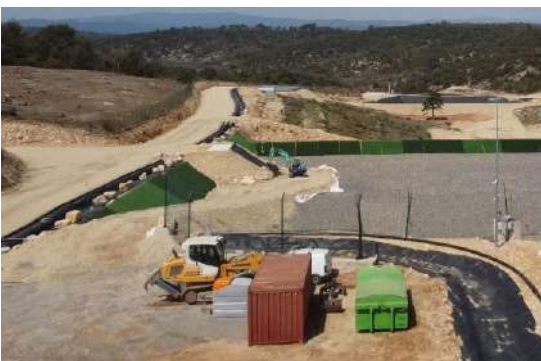
Aire stockage matériel
